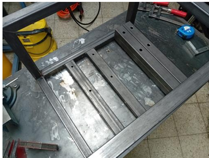
Obrázek 6 – Svařování ocelového rámu
